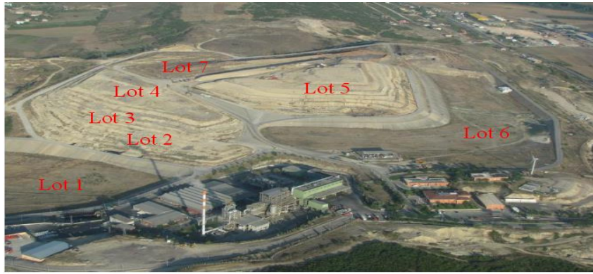
Şekil 3. Solaklar düzenli depolama sahası lotların görünümü
